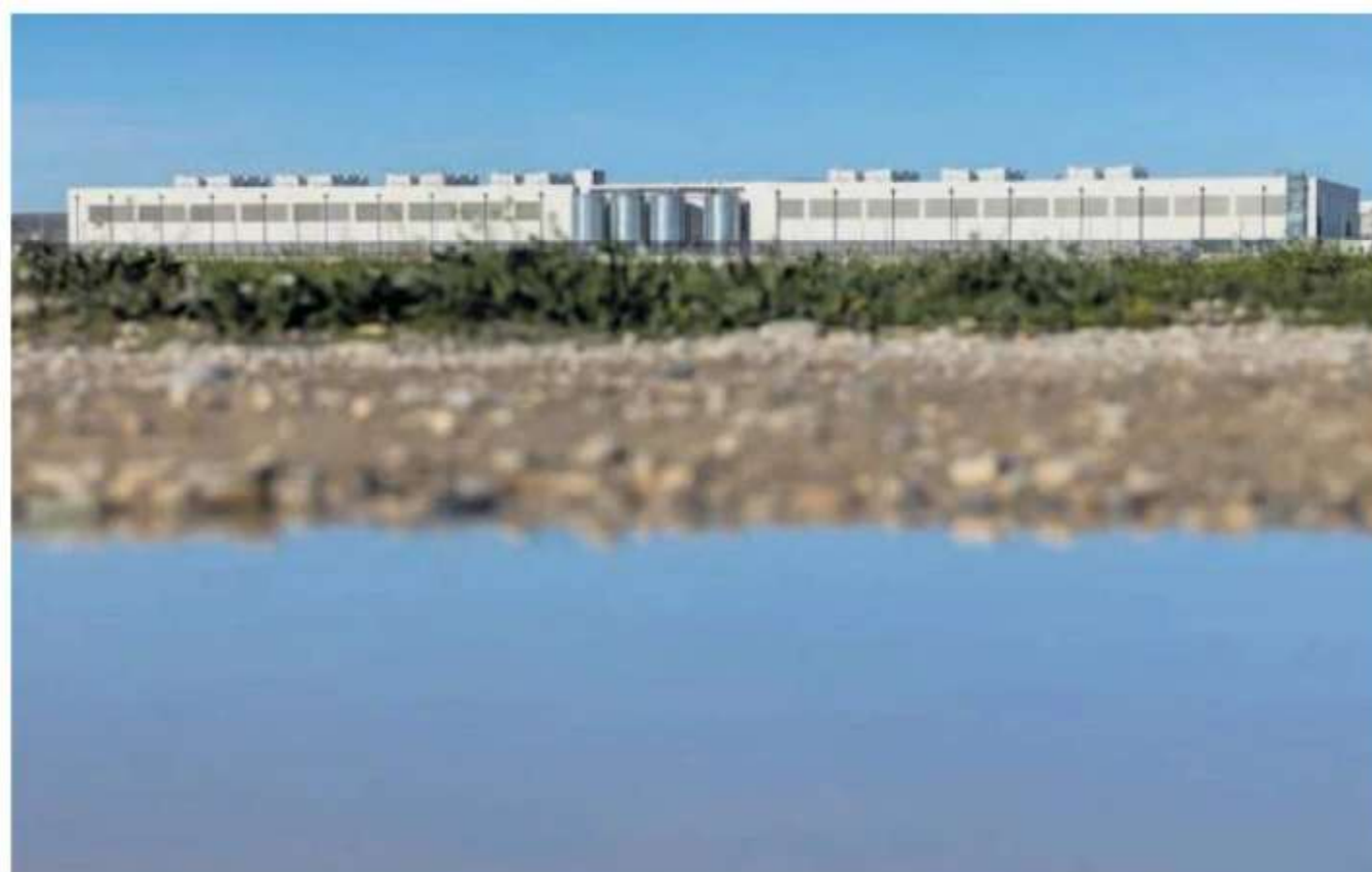
Centro de datos de Amazon en Villanueva del Gállego (Zaragoza). CARLOS ROSILLO
