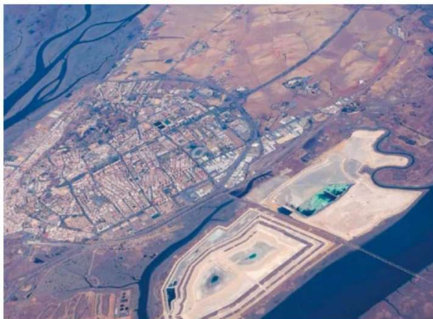
Vista aérea de las balsas de fosfoyesos, en la parte inferior de la imagen, junto a Huelva. PACO PUENTES
